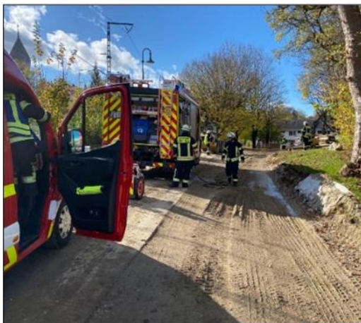
Oktober: Abgerissene Gasleitung Weßling An der Grundbreite
